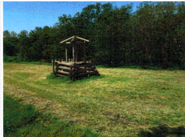
Registro Fotográfico 07 – Estrutura de madeira inserida na Área de Preservação Permanente.
