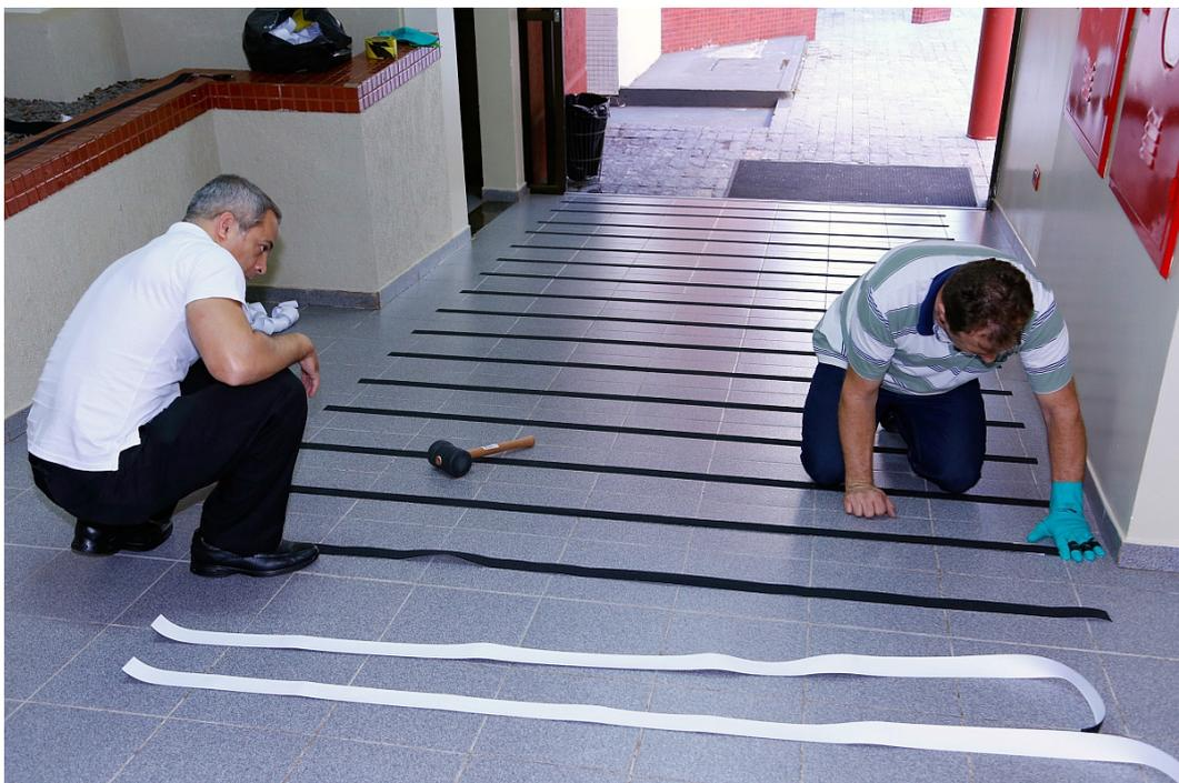
As fitas foram afixadas em locais que, em razão das próprias características do piso existente, apresentam potencial risco de escorregões. As fitas, por sua aderência, amenizam o risco de quedas por parte das pessoas que transitam por esses locais.
